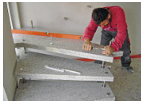
Montage einer freitragenden Treppe mit Fenster bei der dritten Stufe. Die Stufe wird bis in die Fensteröffnung verlängert, sodass kein Geländer erforderlich wird. Der Spalt darf nicht größer als 4 cm sein.
