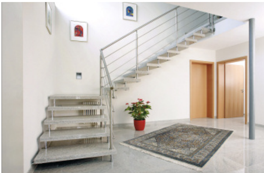
Naturstein, der eine statische Funktion erfüllen soll, muss immer technisch verstärkt werden. Das klassische Beispiel ist die freitragende Treppe.
