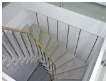
An der Stirnseite der Treppe konnten keine Wandanker montiert werden. Also wurden die Stufen im Mittellauf der Treppe von oben abgehängt.
