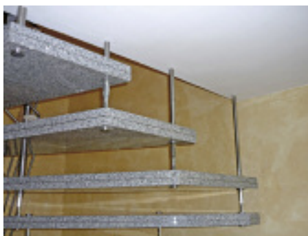
Die letzten Stufen werden unter die Rohdecke gezogen, sodass sie einfach abgehängt werden können.
