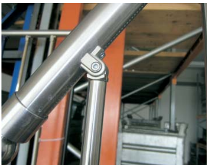
Wer keine Staketenlöcher in den Handlauf bohren möchte, kann sich dieser Gelenkstücke bedienen
