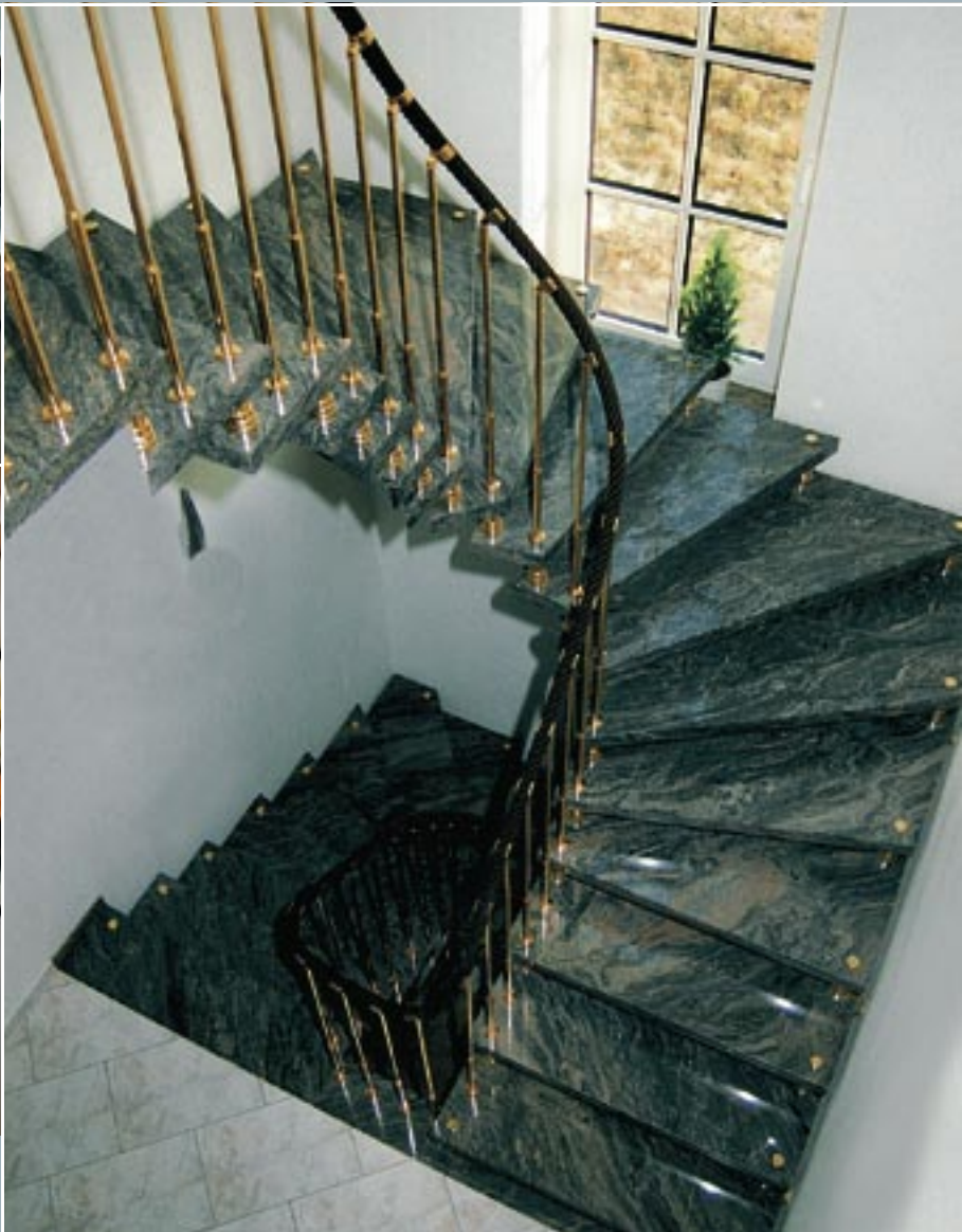
Die variablen Kugelverbindungen ermöglichen die Anpassung des festen Handlaufes an die Treppenform.
